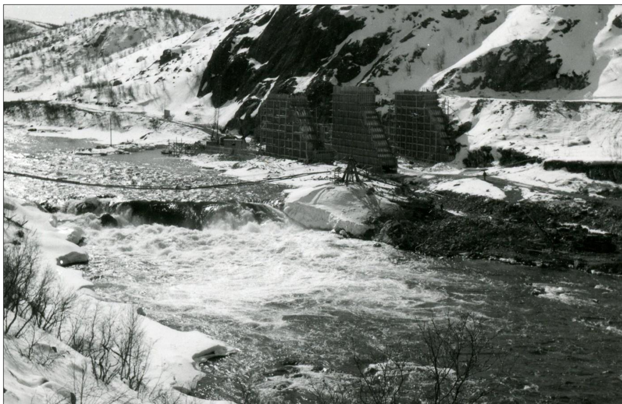
МОМ ОФ-15441/3776-8. Борисоглебская ГЭС. Строительство машинного зала. Видны шахты агрегатов. 1962 г.
