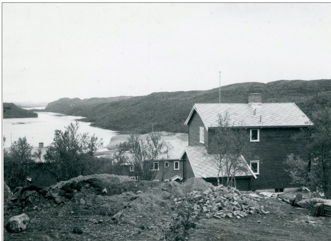
МОН ОФ-15435/1292-66. Борисоглебская ГЭС. Дома постоянного поселка для эксплуатационного персонала. Сентябрь 1962 г.
