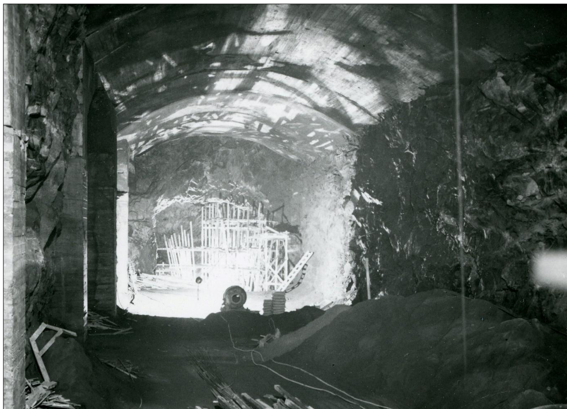
МОН ОФ-15435/1292-12. Борисоглебская ГЭС. Левая ветвь уравнильной камеры в период строительства. Лето 1962 г.
