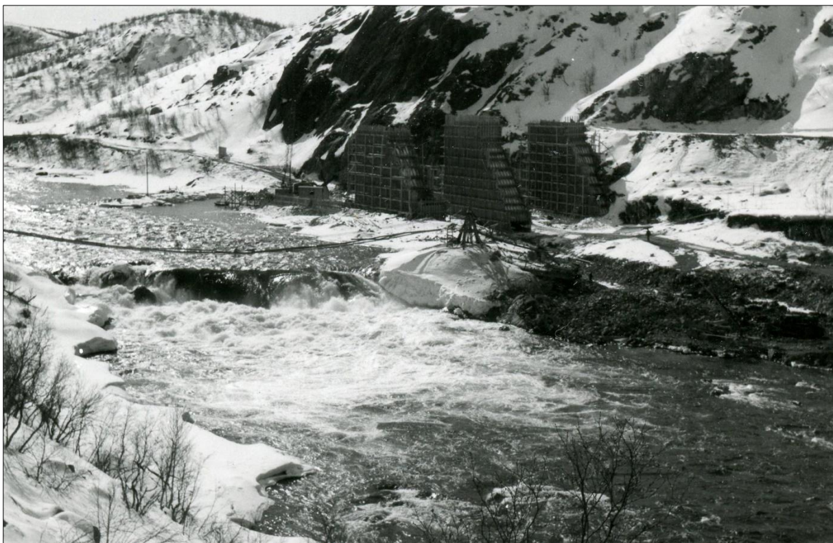
МОМ ОФ-15435/1292-8. Борисоглебская ГЭС. Водопад Сколтенфосс (Борисоглебский) до перекрытия русла реки Паз и быки водосброса. Зима 1961 г.
