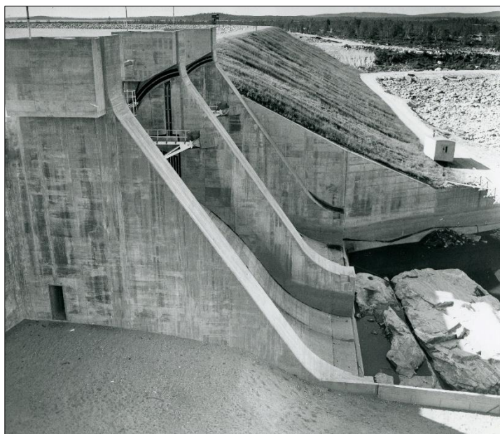
МОМ ОФ-15441/3776-12. ГЭС Хевоскоски. Водосливная часть плотины. Вид на норвежскую сторону. 1970 г.
