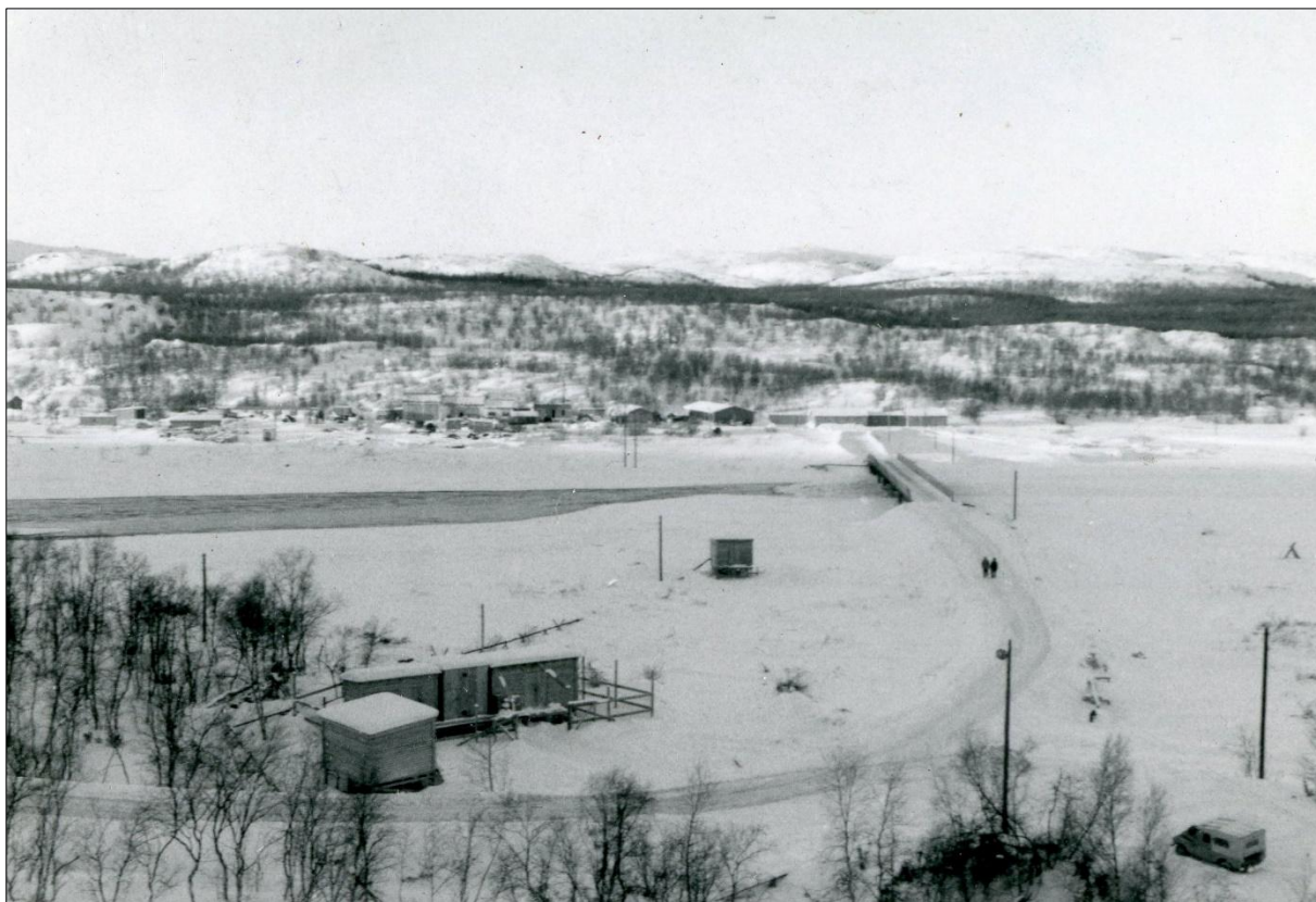
МОМ ОФ-15435/1292-5. Борисоглебская ГЭС. Временный мост и площадка строительства на левом берегу реки Паз. Зима 1961 г.
