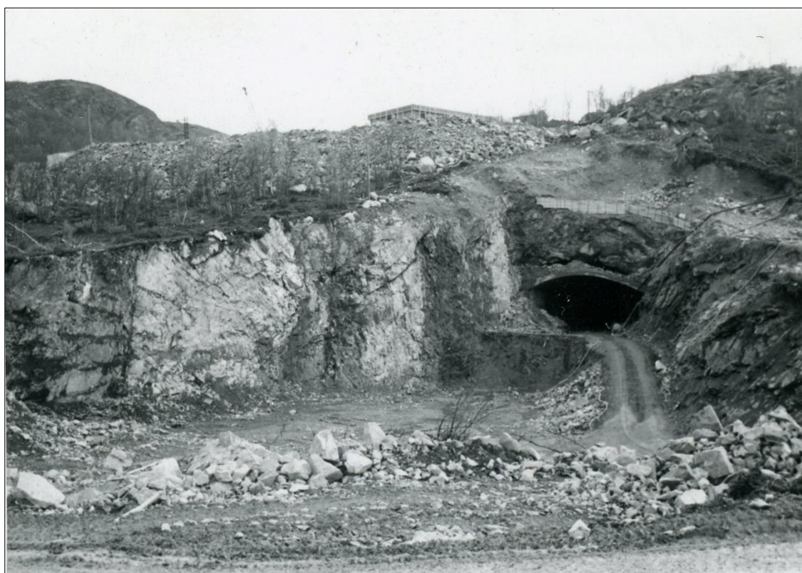
МОМ ОФ-15435/1292-9. Борисоглебская ГЭС. Верхняя часть портала левого отводящего канала (тоннеля) в период строительства. Лето 1962 г.
